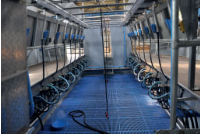
Der Melkstand 2x8 mit Hintenanhängung und Seitenaustrieb wurde in einen halbeingestreuten Stall mit Spaltenboden vor dem Fressgitter eingebaut.
